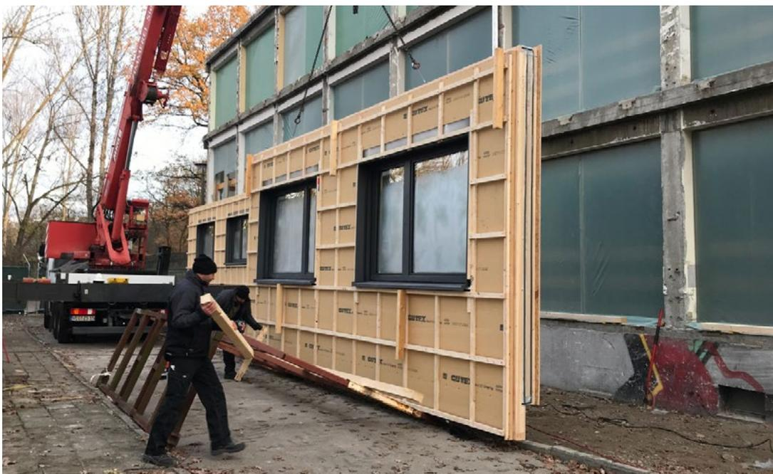
*Abb.3: energetische Sanierung mit Bestandserhalt des Rohbaus, Verwaltungsgebäude Tierpark, ZRS Architekten Ingenieure © ZRS Architekten Ingenieure & Tierpark Berlin*
