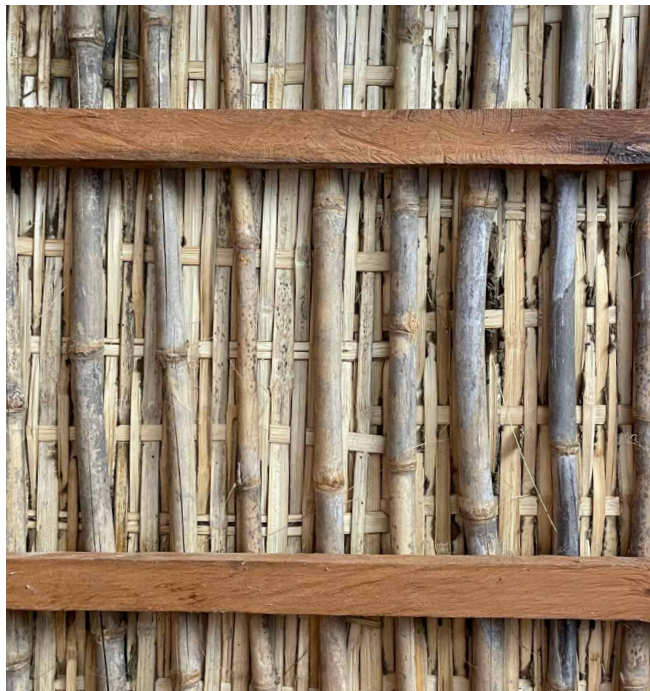
Kanthölzer als Tragwerk für Dächer
