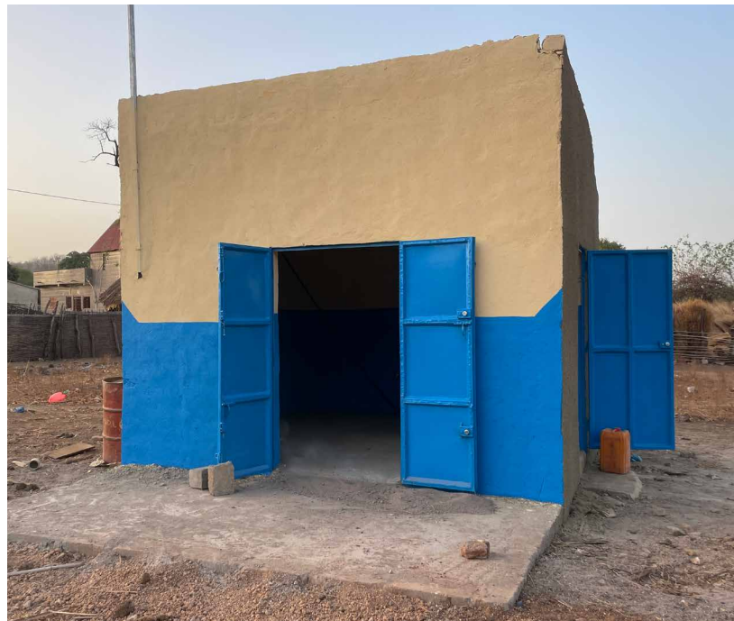
Gewerbeeinheit aus Adobe, verputzt und gestrichen
