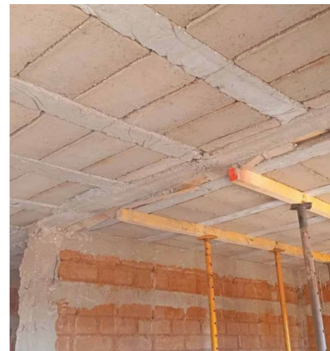
Einhängedecke mit Deckensteinen aus Beton
