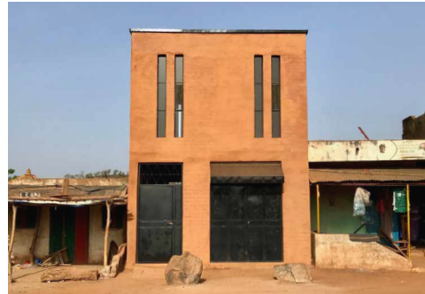
Demonstrationsgebäude „Suddo Neue“, 2019
