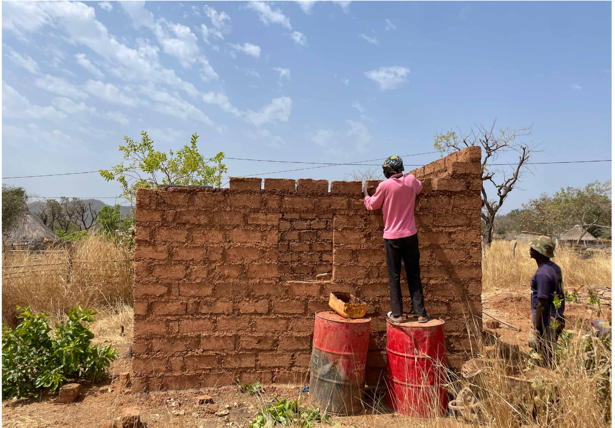
Mauerwerk aus Adobe, Baustelle in Mako, 2025
