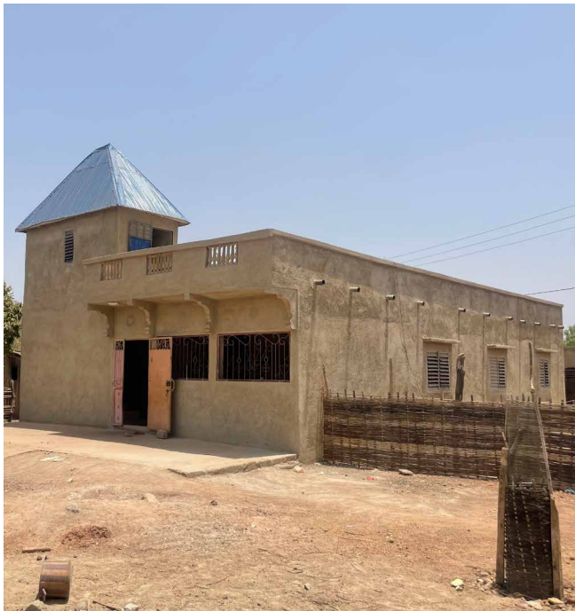
Freistehendes Wohnhaus mit begehbarem Flachdach
