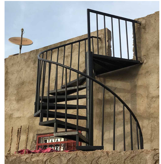
Außenliegende Spindeltreppe an einem Wohngebäude in Mako
