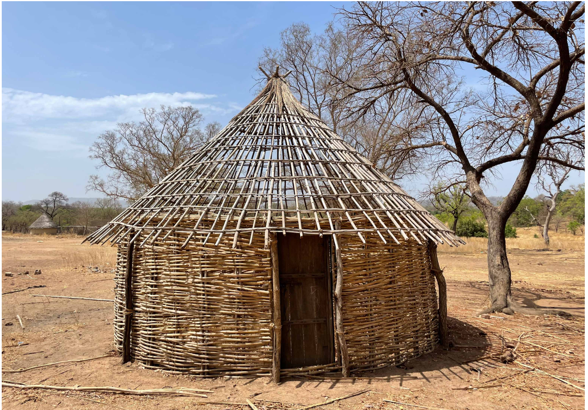
Rundhütte aus Bambus-Flechtwerk im Bau, Niemenike
