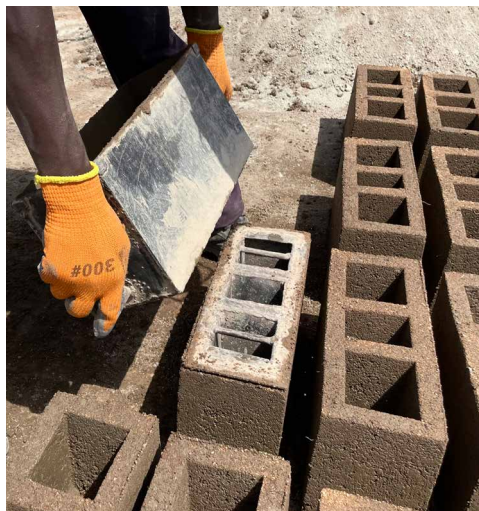
Herstellung von Beton-Hohlblocksteinen
