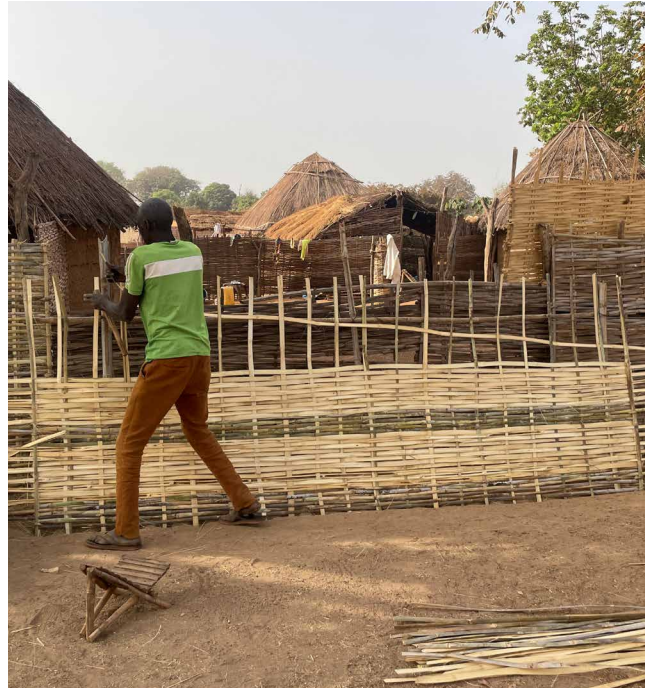
Herstellung von Bambus-Matten für Zäune, Mako
