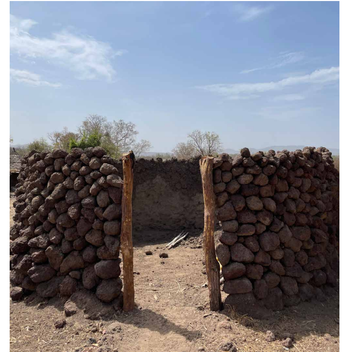
Rundhütte aus Naturstein im Bau, Niemenike
