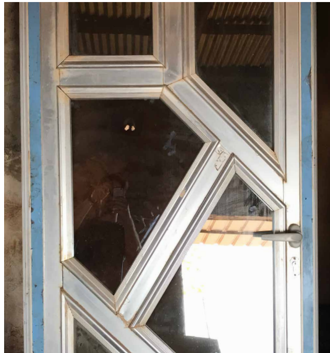
Verglaste Terrassentür aus Alu-Steckprofilen
