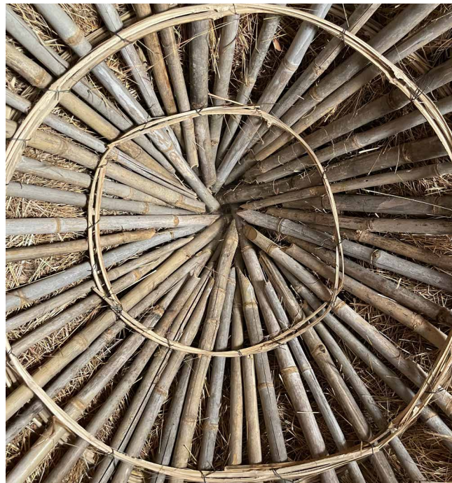
First eines Kegeldaches von Innen
