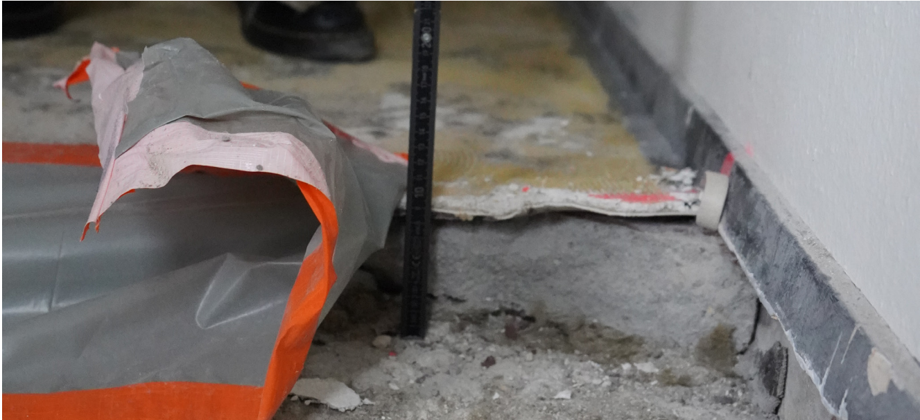
Abb. 28: Teilweise herausgestemmter Bodenaufbau im „Haus 2“ (Seminar Gute Fügung, 2025)
