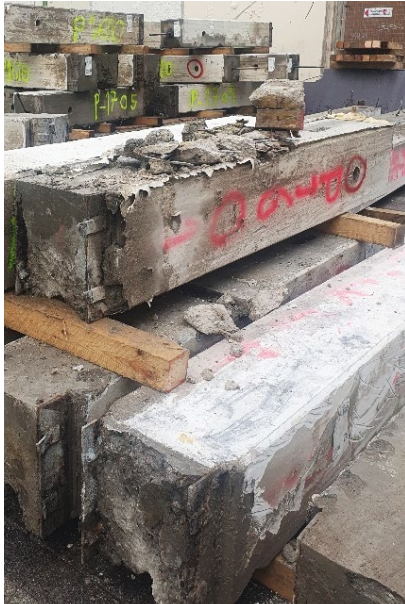
Abb. 47: Lagerung der demontierten Stützen, Foto Emmi Salmio (Vullings et al. 2024b, 26)
